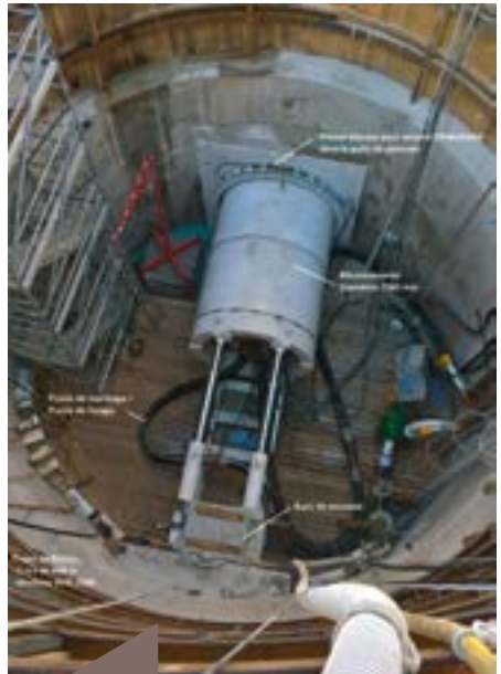
Microtunnelier de Roissy.
